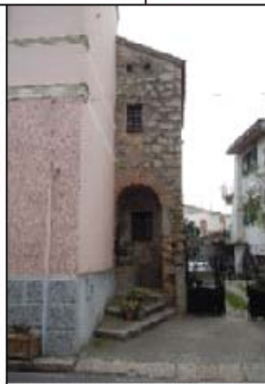
EDIFICIO A PROTEZIONE DEL POZZO
