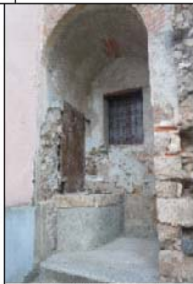
PARTE ESTERNA DEL POZZO
