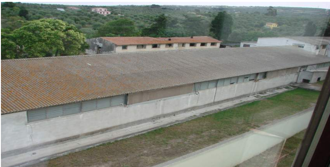
Fig. 36: Allevamento avicolo (vista dall'alto della copertura in eternit)
