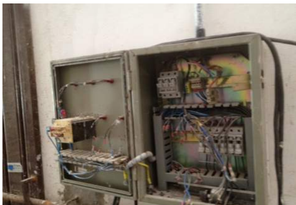
Fig. 24: Interno magazzino – particolare impianto elettrico
