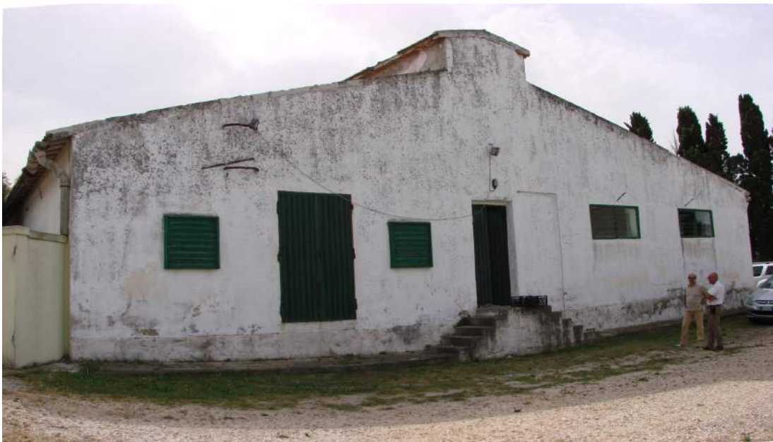
Fig. 19: facciata magazzino lato ovest
