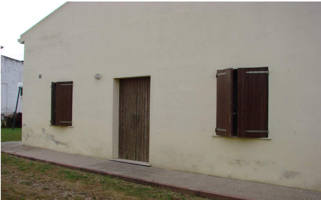
Fig. 12: vista facciata lato nord; particolare infissi
