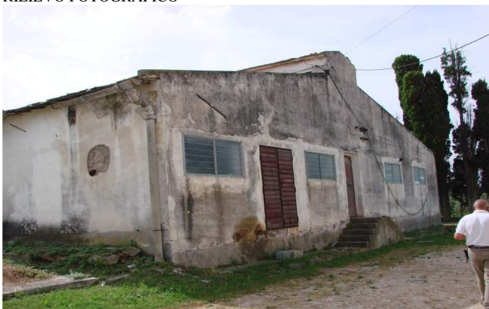
Fig. 27: facciata sud secondo magazzino
