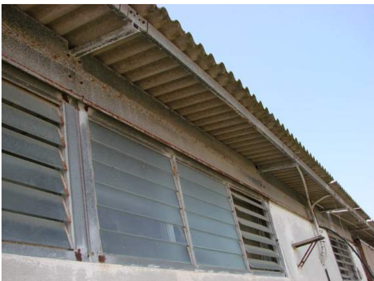
Fig. 38: Allevamento avicolo (particolari degli interni e degli infissi)
