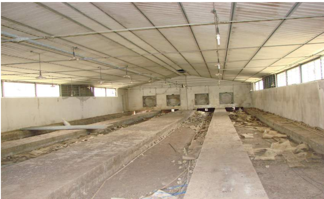
Fig. 37: Allevamento avicolo (vista dall'interno)
