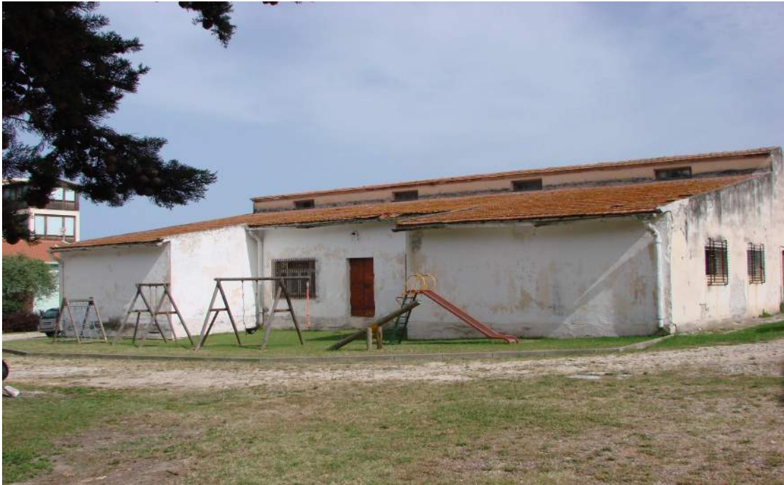
Fig. 20: Facciata magazzino lato sud
