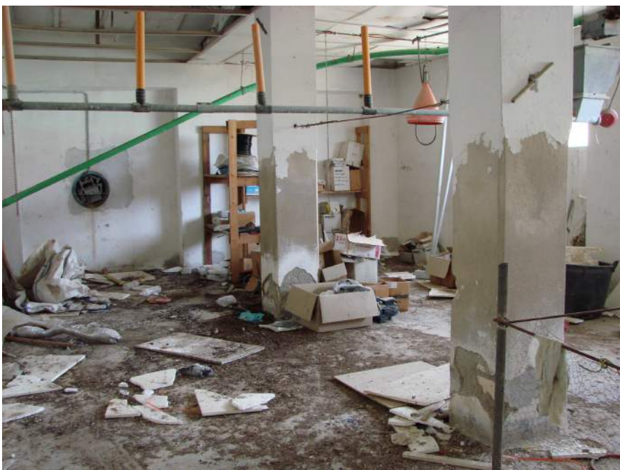
Fig. 22: Interno magazzino (locale appoggio a sud)
