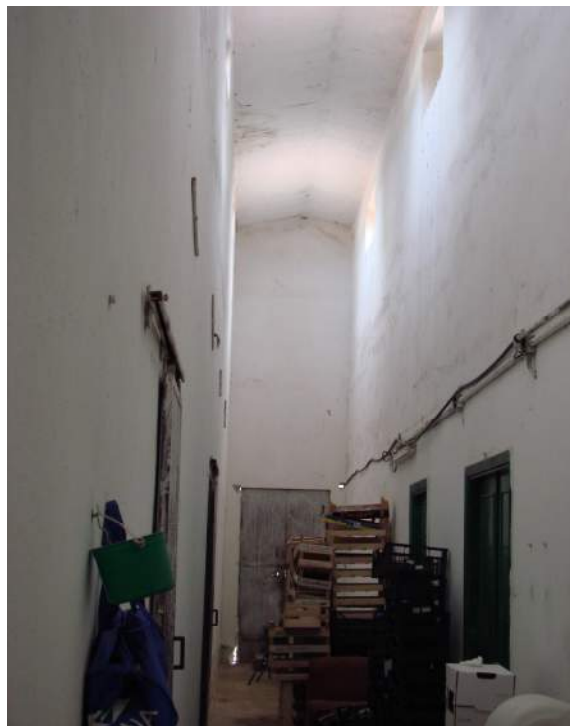
Fig. 32: corridoio centrale del magazzino
